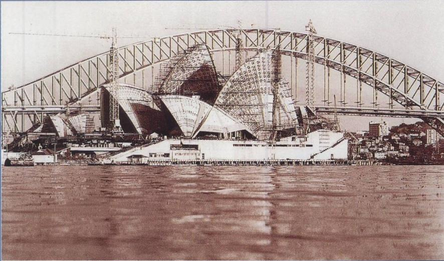
Bau des Opernhauses Sydney 1968 mit Wild T2 und Wild DI10 IR-Laserdistanzmesser/Reduktionstachymeter.
